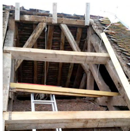
Église de Brenouille - Travaux de toiture Poutres de remplacement.
