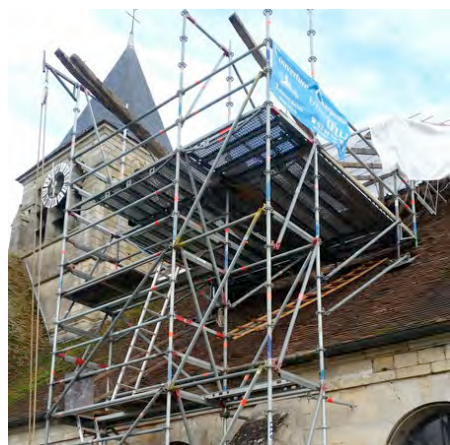
Église de Brenouille - Travaux de toiture Échafaudage côté nord.
