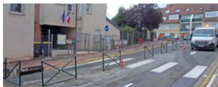
Rue Emile Zola maintenant en sens unique tout le long.
