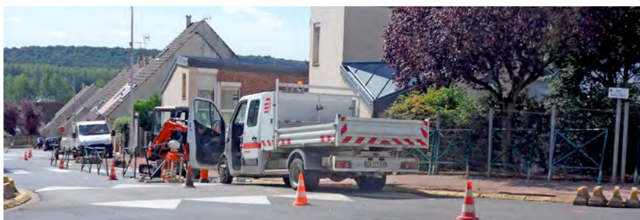
Travaux d'aménagement de voirie devant l'école Berthe Fouchère.
