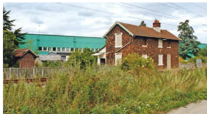
Ancienne maison garde-barrière de l'ancien tracé Brenouille - Pont-Sainte-Maxence devenu aujourd'hui Impasse de Gilocourt et Allée des Artisans. (Repère D en page de droite)
